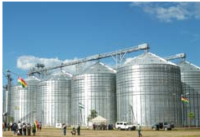
Fornalhas da Weco secam grãos nos grandes silos para produtos agrícolas
